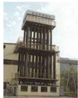
コンデンサータワー
