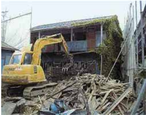
瓦等不燃物を事前撤去、重機で木屑と鉄に分別解体
