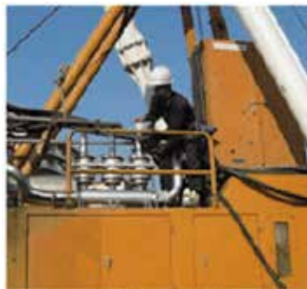
モコビーの取付工事
