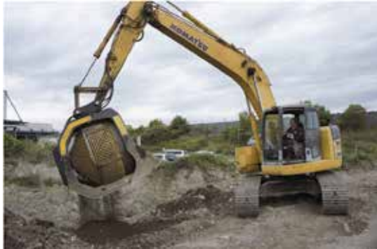
木片、質の異なる岩石やコンクリートガラ等、様々な瓦礫をスクリーングバケットと油圧ショベルでふるい分け
