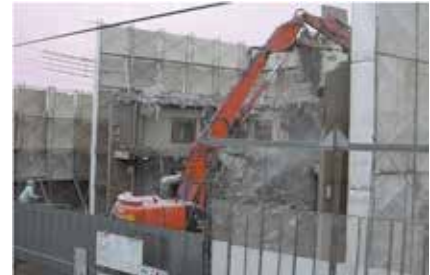
コンクリート造、鉄骨造、木造の解体
