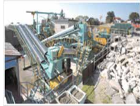
建設廃材（コンクリートくず、コンクリート廃材）の骨材破砕機による再生砕石、販売
