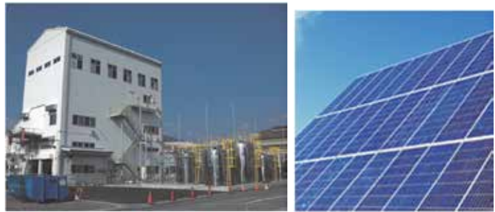
LIB（リチウムイオンバッテリー）を初めとした各種バッテリー用電解液の製造や、CO 2 削減に効果的な太陽電池の製造にも、取り組んでいます。
